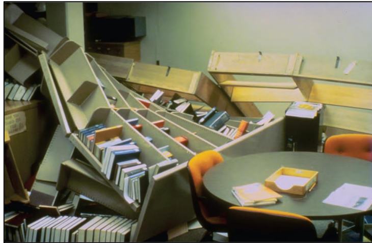
Fig. 4.6. Caída de mobiliario metálico y de madera sobre el suelo, pudiendo aprisionar a las personas y obstaculizar el paso
