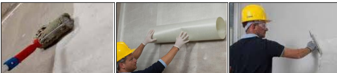
Fig. 8.2 Aplicación de adhesivo monocomponente, malla de fibra de vidrio y enlucido de mortero sobre la superficie del soporte.
