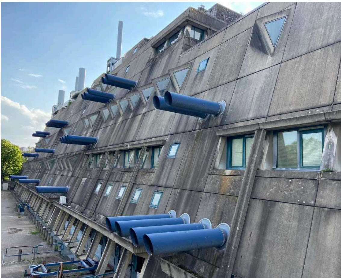
Fig. 3. Vista exterior del Mäusebunker. 2021. Imagen propia.
