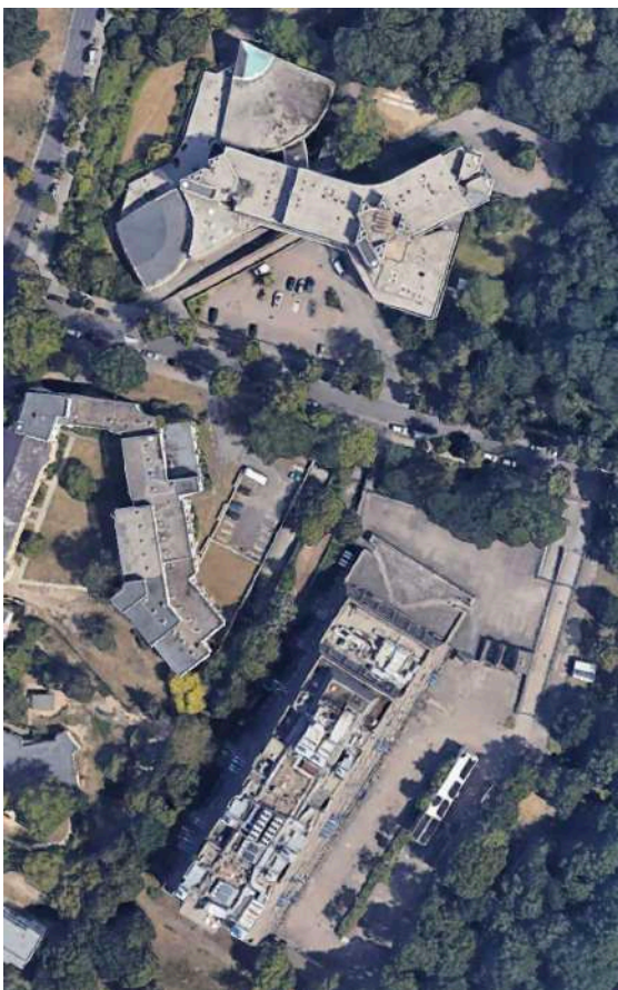
Fig. 1. Vista aérea de los dos edificios en el Campus de Charité, a ambos lados de Krahmerstrasse. 2022. 52°26'15" N and 52°13'19.12" E. Google Earth. 20 julio 2022. 18 marzo 2023.
