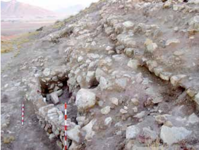
Fig. 15. Plataformas de aterrazamiento y muros de mampostería de la ladera meridional de Terlinques.
