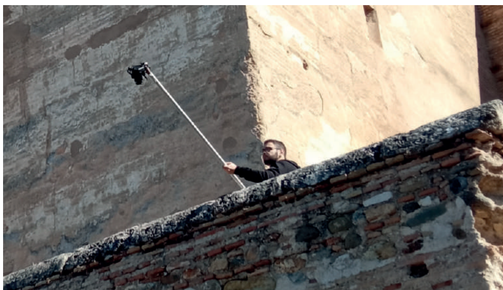
Figura 1. Proceso de fotogrametría manual con pértiga
