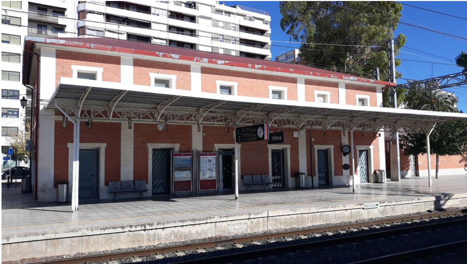
Figura 6. Vista de la estación de Villena desde los andenes, donde se aprecia el cambio de estilo arquitectónico con respecto al estándar. Fotografía: autor, noviembre de 2019.
