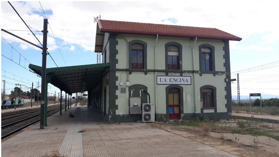
Figura 7. Imagen lateral del edificio de viajeros de la estación de La Encina, donde se aprecia el cambio de color de la cubierta, en este caso en rojo, de uno de los cuerpos laterales de la construcción. Fotografía: autor, noviembre de 2019.
