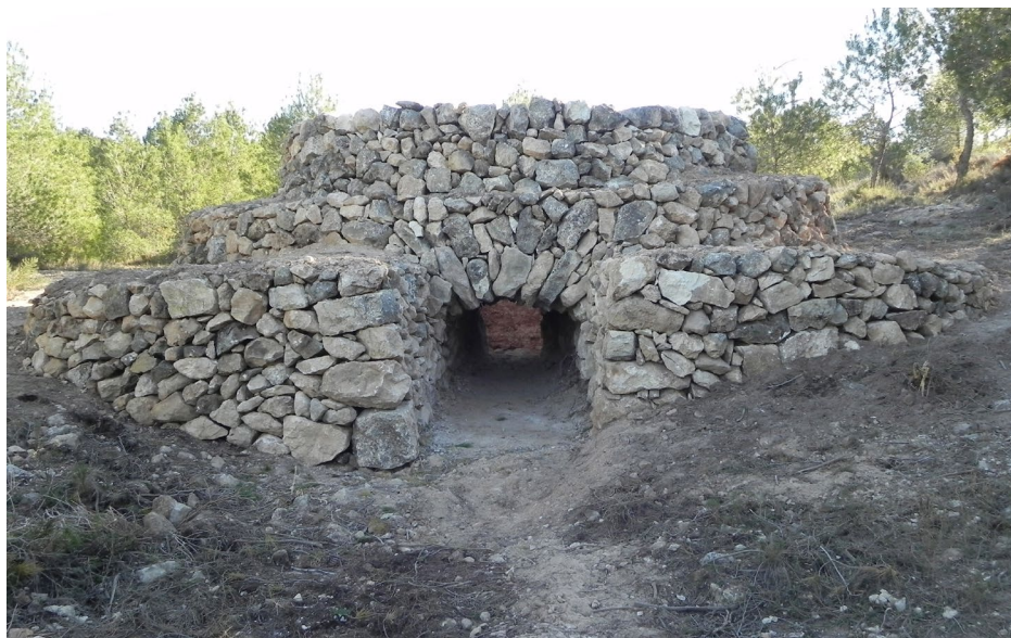
Figura 7. Aspecto final del horno de cal tras su rehabilitación. Frente norte del horno, con su boca y tiro recuperado. Fotografía: ARPA Patrimonio.
