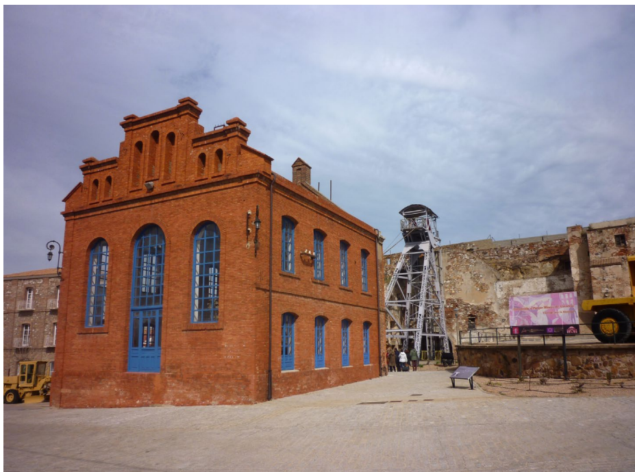
Figura 7. Pozo San Aquilino en el Conjunto minero de Almadén (Ciudad Real).
