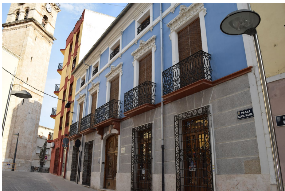
Figura 1. Fachada de la Casa Modernista de la Comparsa de Labradores. Fotografía: Miguel Ángel Jiménez.
