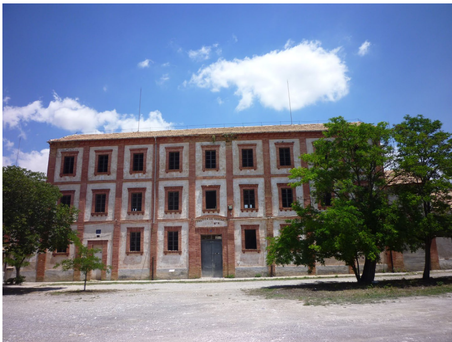
Figura 2. Fábrica de harina en la Colonia agrícola de Santa Eulalia, en Sax-Villena (Alicante).
