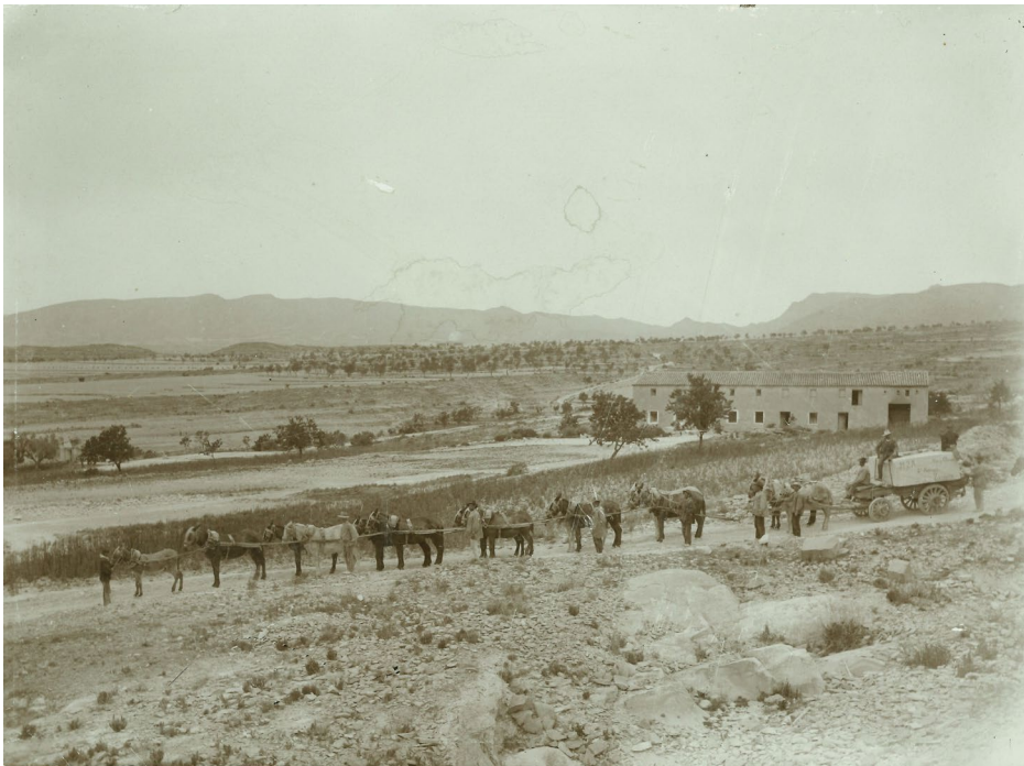
Figura 4. Reata de 14 mulas y 10 canteros portando la cureña con bloque de piedra Bateig con destino a la estación de ferrocarril de Novelda. Hermanos Ramón y Pedro García Romero. Primera década del siglo xx. Novelda. Fuente: Museo Comercial de Alicante y provincia.
