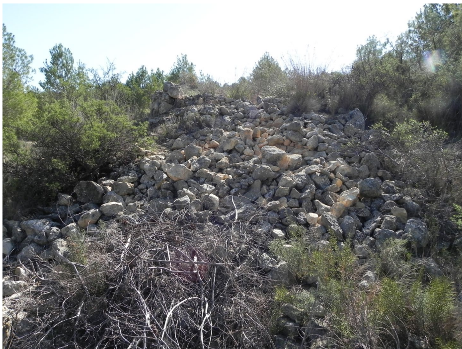
Figura 5. Calera de la Torreta totalmente desmantelada a principios de diciembre de 2014, antes de su rehabilitación. Fotografías: ARPA Patrimonio.
