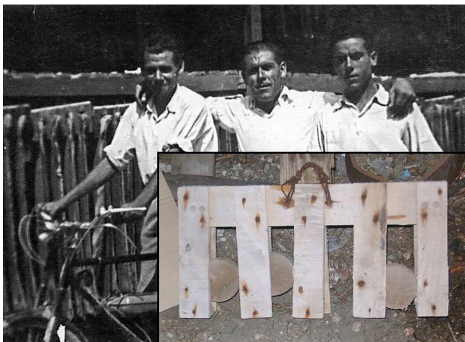
Figura 7. Pieza en forma de peine utilizada en los secaderos (delante) y secaderos de cartón de la fábrica de Casas de Santo en 1952 (fondo).
