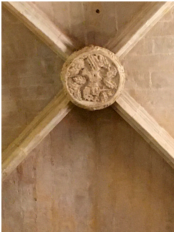
1. Escudo de Pedro IV "El Ceremonioso" situado en la bóveda del primer tramo de la nave central (siglo XIV).
