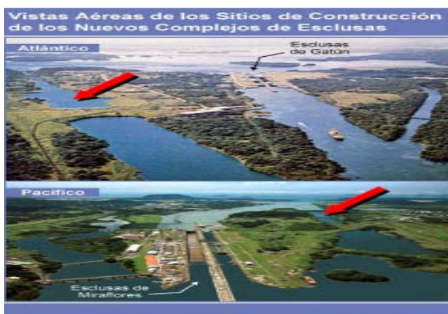
Figura 33 El proyecto del tercer juego de esclusas se construirá en el sitio de las excavaciones de 1939 dentro de áreas de funcionamiento del Canal.
