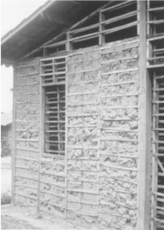
Fig. 2. Bahareque con elementos prefabricados, Brasil. Fuente: Minke (2005)
