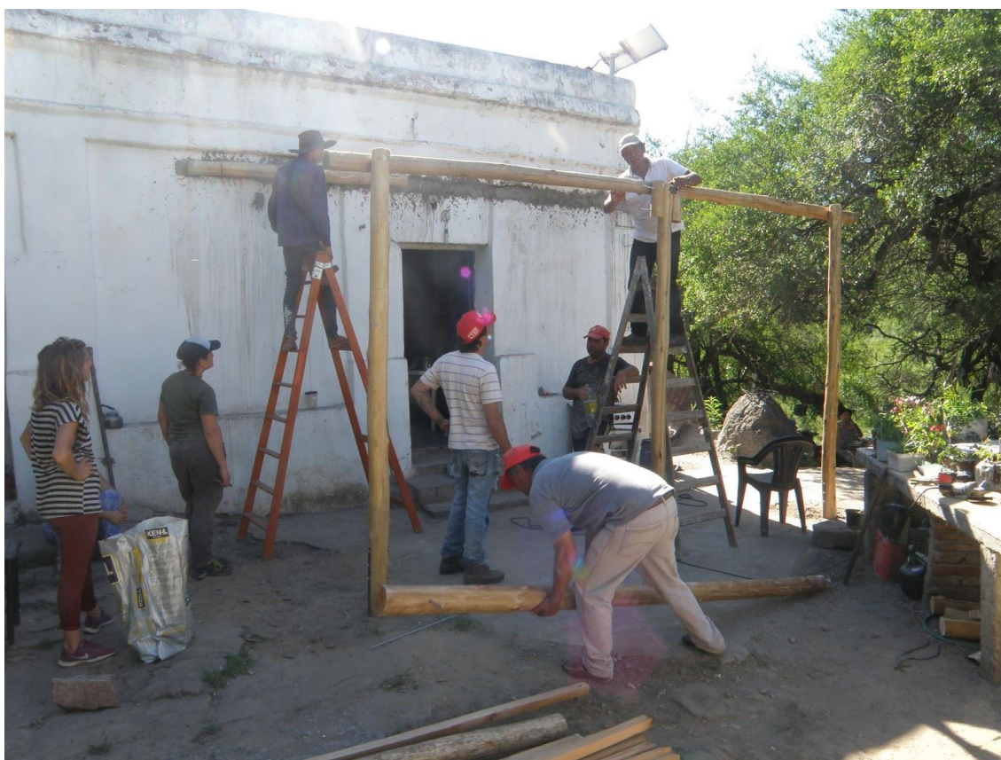
Fig. 5. Proceso colectivo de mejoramiento de espacio productivo para la cosecha de miel (galería) en vivienda campesina de adobe en zona de Tulumba, Córdoba, Argentina. Fuente: autoría propia (2019).
