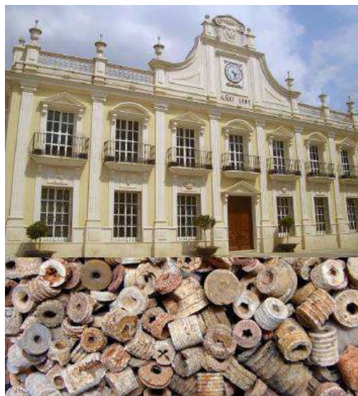
Fig. 1: fachada del Ayuntamiento de Cabra. Empleo de Caliza Oolítica del Jurásico Medio con presencia de abundantes Crinoides.
