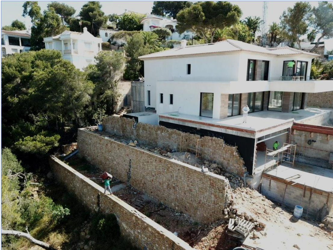
Figura 8. Construcción de muros de piedra seca en Xàbia, 2021. (Fuente: Urbimed Villas)
