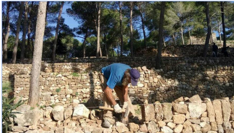
Figura 7. Restauración de muros en el Castillo de Dénia (Fuente: Periódico La Marina Plaza , 2018)
