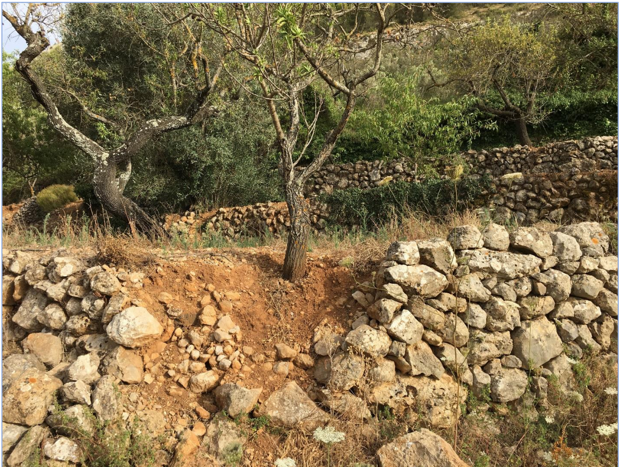
Figura 15. Desprendimientos (*solsides) en muro de piedra en La Vall de Laguar, 2021. (Fuente: elaboración propia)
