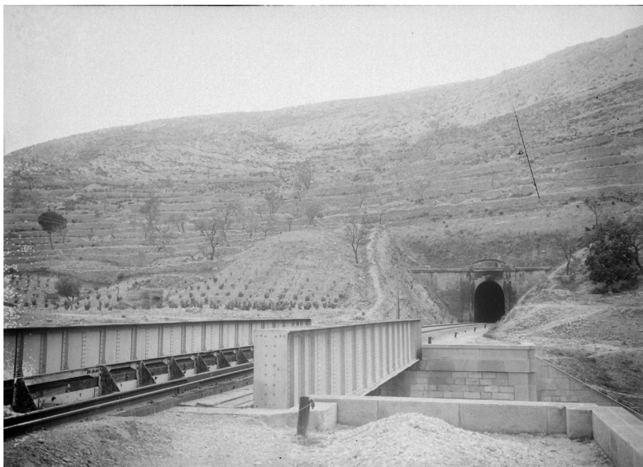
Figura 3. Túnel y puente sobre el río Vinalopó en el km 412,100 de la línea de Madrid a Alicante, situados en el término de Elda. Fecha: 21/09/1921. Signatura: MZA- 1133-IF_9-9- Fuente: Archivo Histórico Ferroviario del Museo del Ferrocarril de Madrid-Fundación de los Ferrocarriles Españoles (Colección: MZA - Servicio Vía y Obras. Fotografía de Juan Salgado Lancha).
