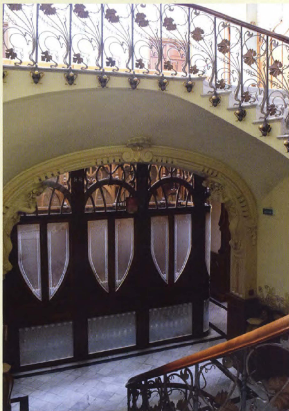
Fig. 15a: Encuentro de la caja de escalera principal con la galería del primer piso (foto: autor, 2018).
