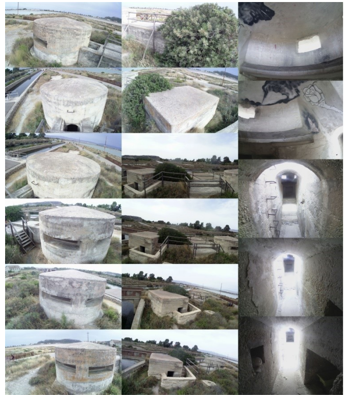
Figure 14. Sector 2: photographic survey (N. Paba).
