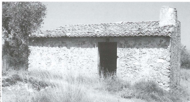
Imatge d'una caseta a Banyeres de Mariola, tipus AR-H-R-Ca, d'una crugia paral·lela a façana.
