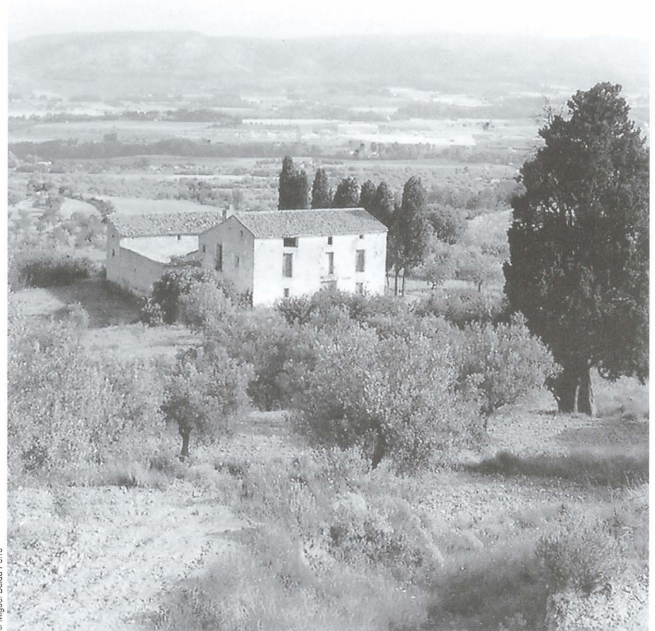
Imatge del mas de Perolít, tipus AR-H-P-Ma a Banyeres de Mariola, amb un volum principal de dos crugies paral·leles a façana.
