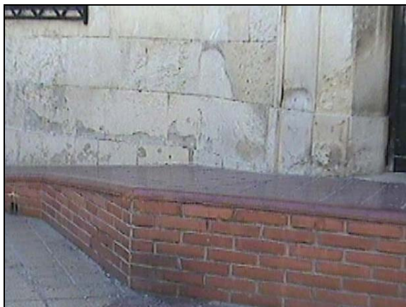
Figura 3. Zócalo de la fachada Noroeste.
