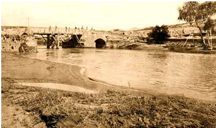
Fig. 9 Puente de madera, Guardamar 1901
