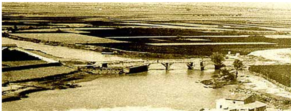
Fig. 10 Detalle del puente de madera sobre el río Segura, Guardamar
