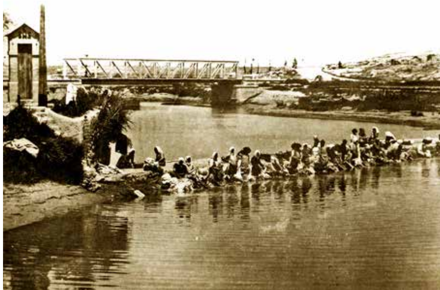
Fig. 17 Mujeres lavando. Azud río Segura, Guardamar
