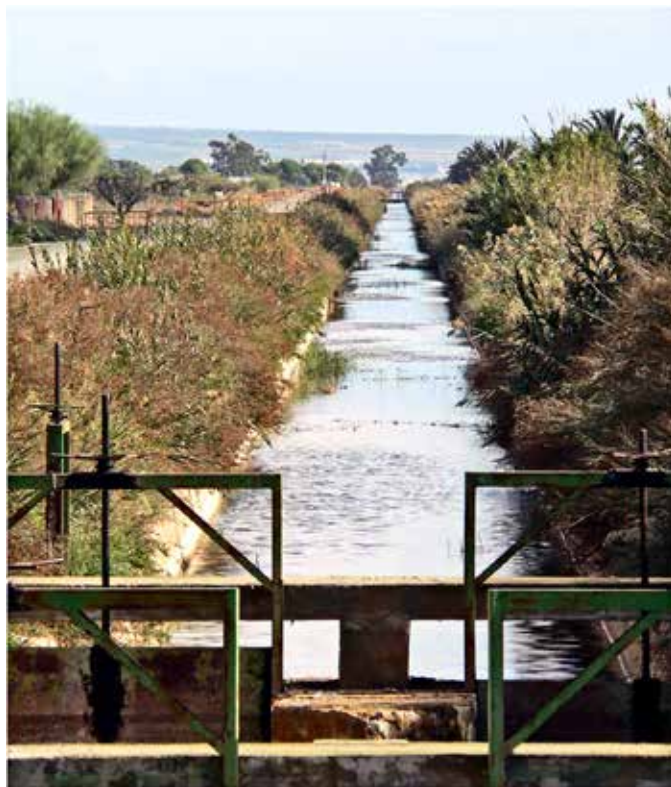
Figura 6: El Canal principal de Regs de Llevant (marge esquerre del Segura) que ara condueix fins el Fondo d'Elx-Crevillent les aigües del riu i les assarbs que abans, en estanyar-se al terme històric de Guardamar (incloent, doncs, Sant Fulgenci) , creaven l'almarjal de l'Augella.
