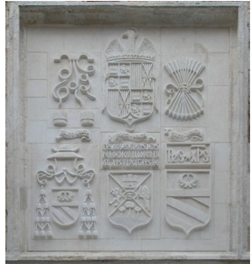
Aspecto actual del panel heráldico fachada de cabecera iglesia Arcedial de Santiago después de su reposición en el año 2008.
