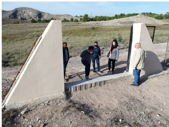
Fig. 8. Visita tras la finalización de las obras de mejora realizadas en Cabezo Redondo durante el verano del 2020.
