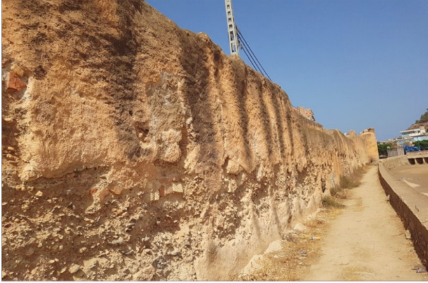
الصورة رقم 05: تبين جزءا من السور الشمالي المبني بمادة الطابيا pize في مدينة هنين العتيقة .
