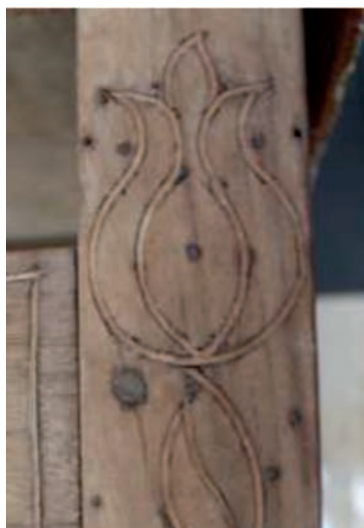
Fig. 14. Detalle de orificios de carcoma rellenos de cera. Foto: Elisa Martínez Zerón.
