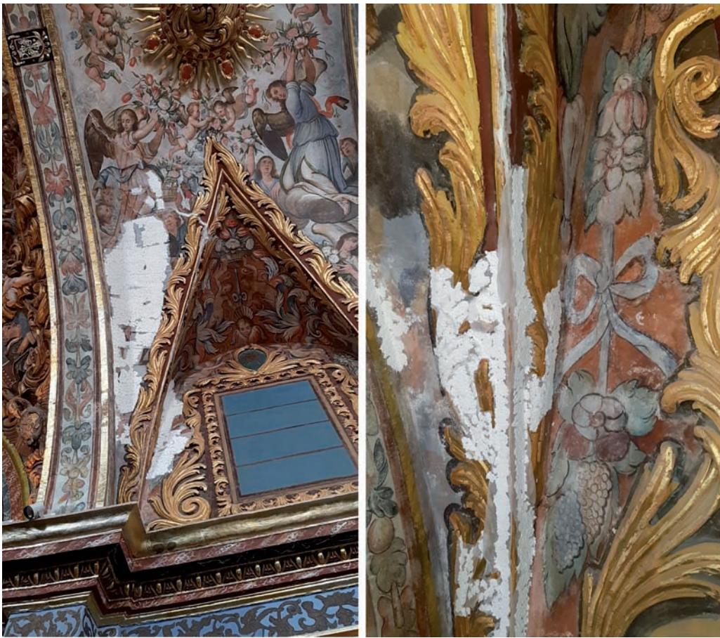
Fig. 18. Aplicación de pulpa de celulosa para la eliminación de sales. Foto: Marina Albaladejo Cerezo.
