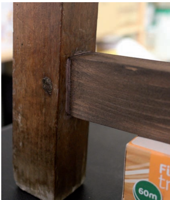
Fig. 40. Detalle proceso de eliminación astillado de la espiga rota. Foto: Elisa Martínez Zerón.
