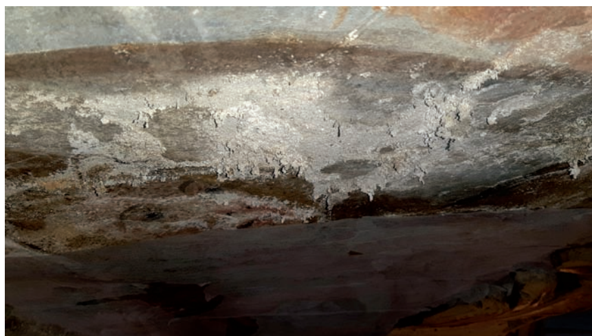
Fig. 14. Inicio del empapelado de preconsolidación en zona de eflorescencias salinas. Foto: Marina Albaladejo Cerezo.
