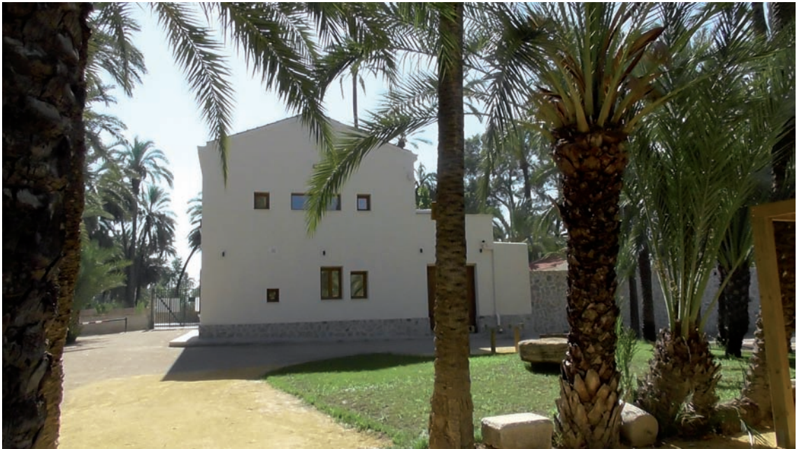
Fig. 10. Fachada de Poniente de la Casa de los Verdú. Dentro del edificio se exponen “Cinco poemas para un interior”. Y en el andador inmediato —el del sur— comienza la muestra de “Veinticinco poemas andadores”. Foto: Miguel Ruiz Martínez.
