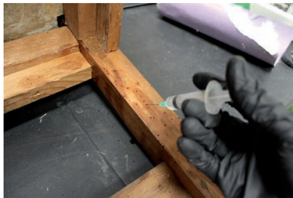
Fig. 27. Detalle del proceso de desinsectación mediante inyección. Foto: Elisa Martínez Zerón.
