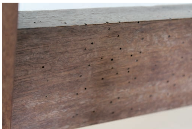
Fig. 17. Detalle de ataque de insectos xilófagos. Foto: Elisa Martínez Zerón.
