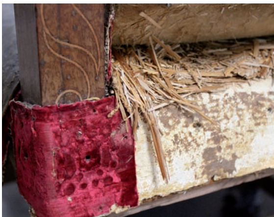
Fig. 12. Detalle de los restos de terciopelo original cortado y la paja que se introdujo como relleno. Foto: Elisa Martínez Zerón.
