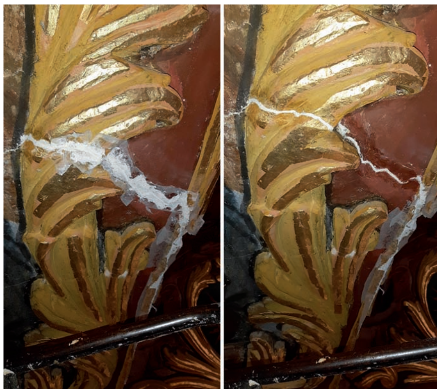
Fig. 17. Protección, sellado y posterior retirada de los restos del tratamiento en una de las grietas. Foto: Marina Albaladejo Cerezo.
