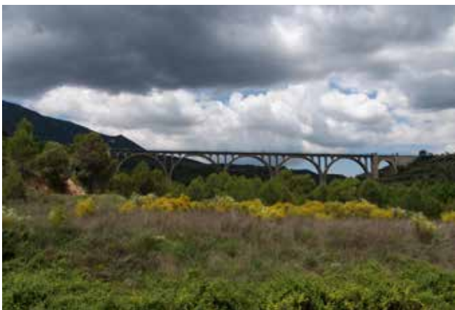
Fig. 13: pont del riu Polop (longitud de 230 metres i una altura de 46 m). En premsa de la època, va ser considerat el major d'Espanya i un dels majors d'Europa. El pont està format per huit arcs en total. Cal indicar que les construccions reben el nom del riu on estan emplaçats. Tenint en compte açó convé esmentar que el nom del pont de les Set Llunes és incorrecte i aquest pont s'anomena pont de riu Polop . El pont de les Set Llunes està ubicat al barranc de la Batalla.
