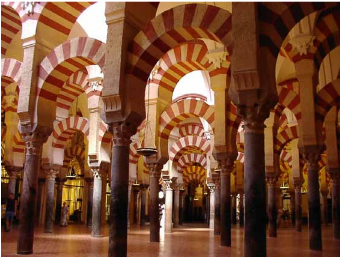
Fig. 5: Bandas rojas de los arcos la Mezquita de Córdoba pintadas con Colcótár (óxido de hierro). Foto José Ubay Suárez Navarro.
