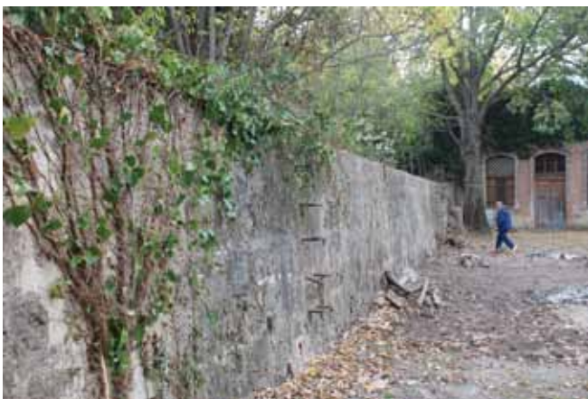
Figura 12. Balsas de decantación en el edificio denominado Fco. Moltó
