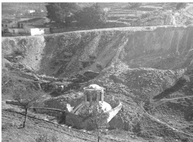
Figura 17. Deslizamiento de tierras sobre el edificio de la Fuente del Molinar en 1974.
