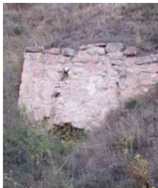
Fig. 4: entrada al Puntal de la Mina
