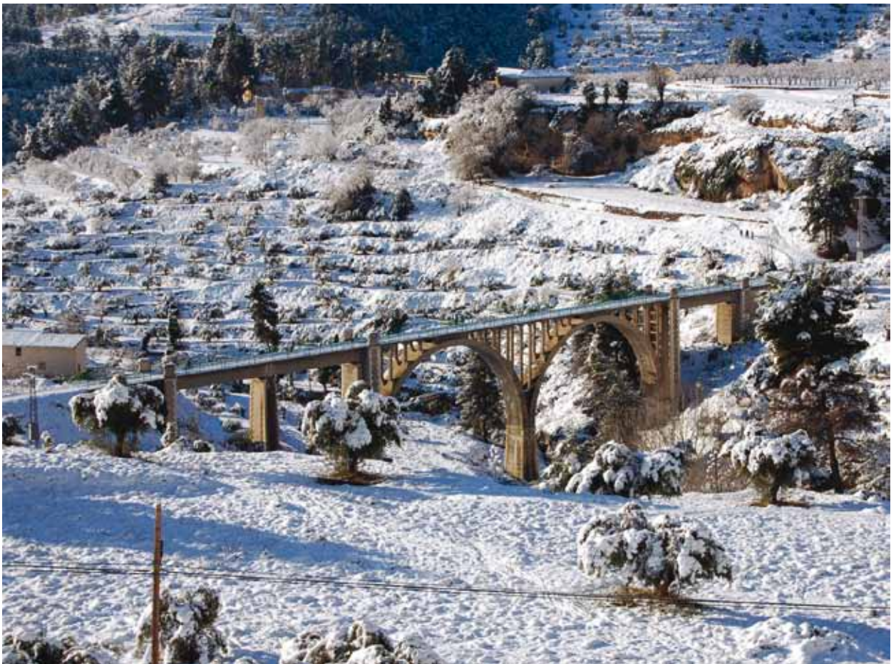
Fig. 4: pont del riu Barxell
