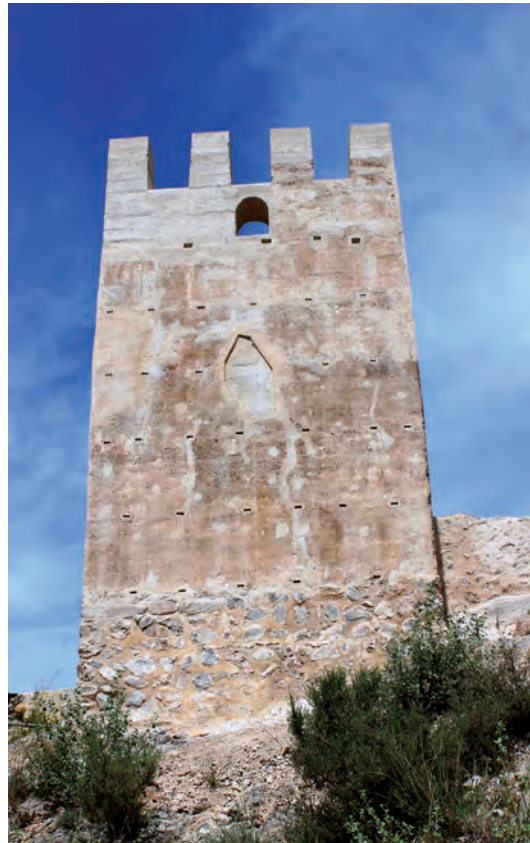
Fig. 3. Muralla de Levante. Torre taifal, recientemente restaurada.
