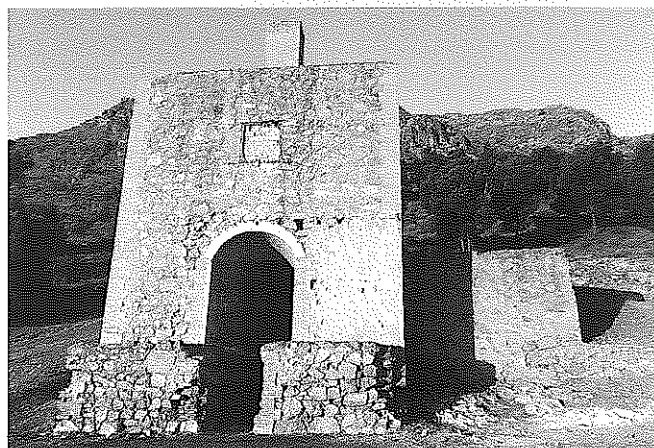
FIG. 1 Vista general del Horno de Santa Matilde
