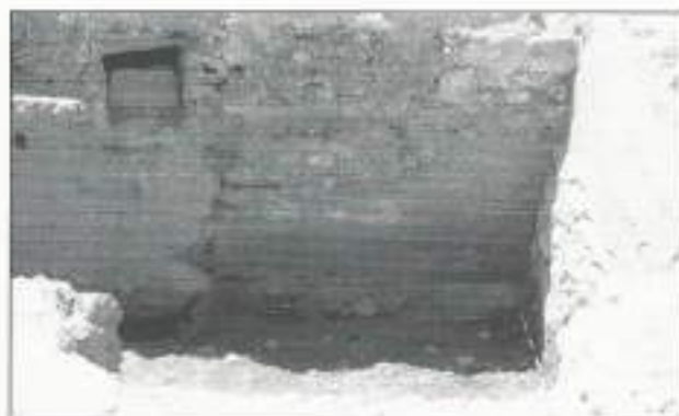
Fig. 9. Tramo I y II en fase de excavación, se aprecia la zona de unión de los dos tramos de muralla.
