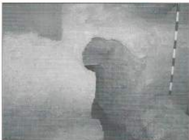
Fig. 10. Paramento interno del Tramo II, se aprecia una atarjea que atraviesa este tramo y va hacia la sala fría de los baños, procedente del interior de la ciudad.
