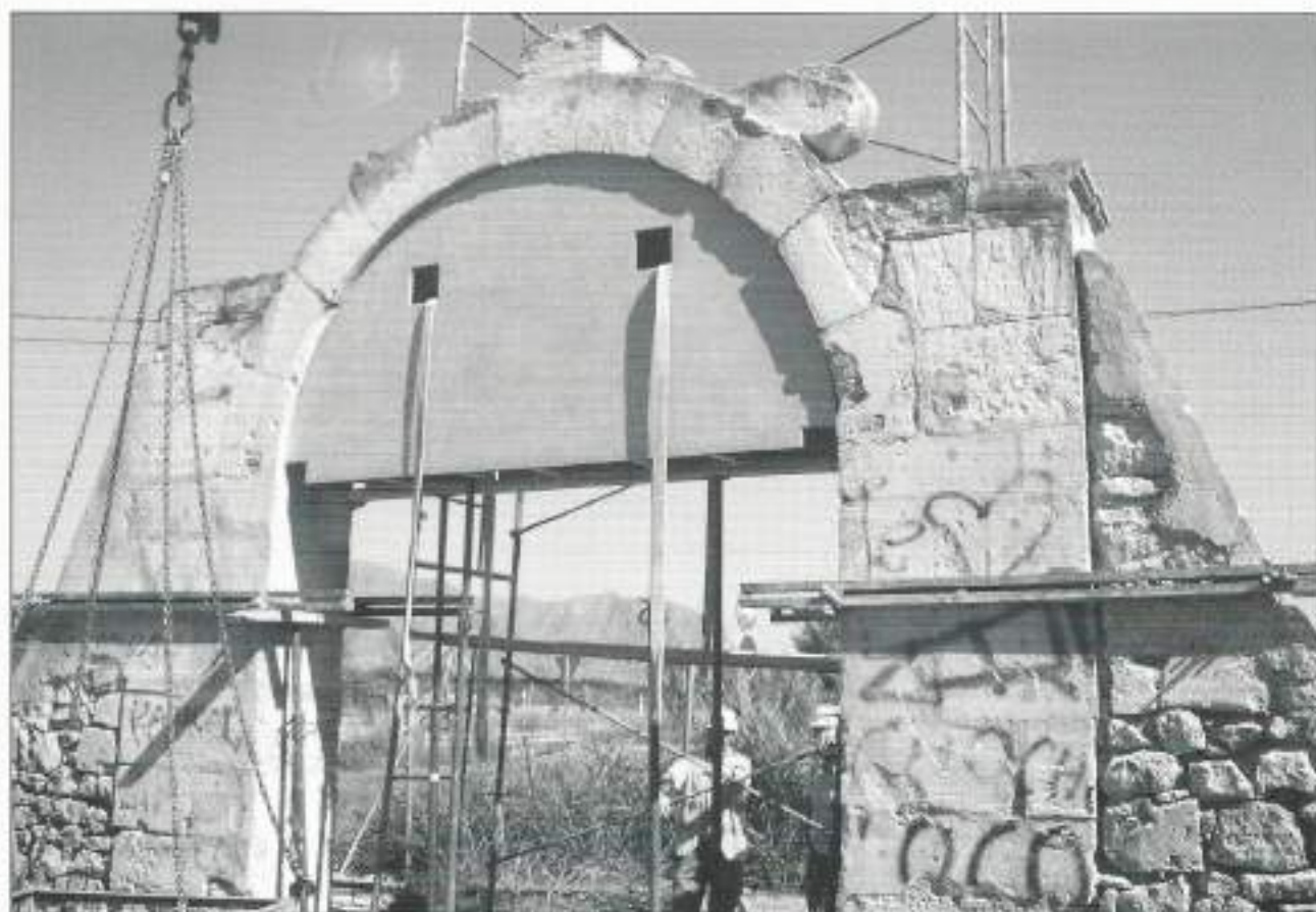
Fig. 3. Colocación del formero para desmontaje
