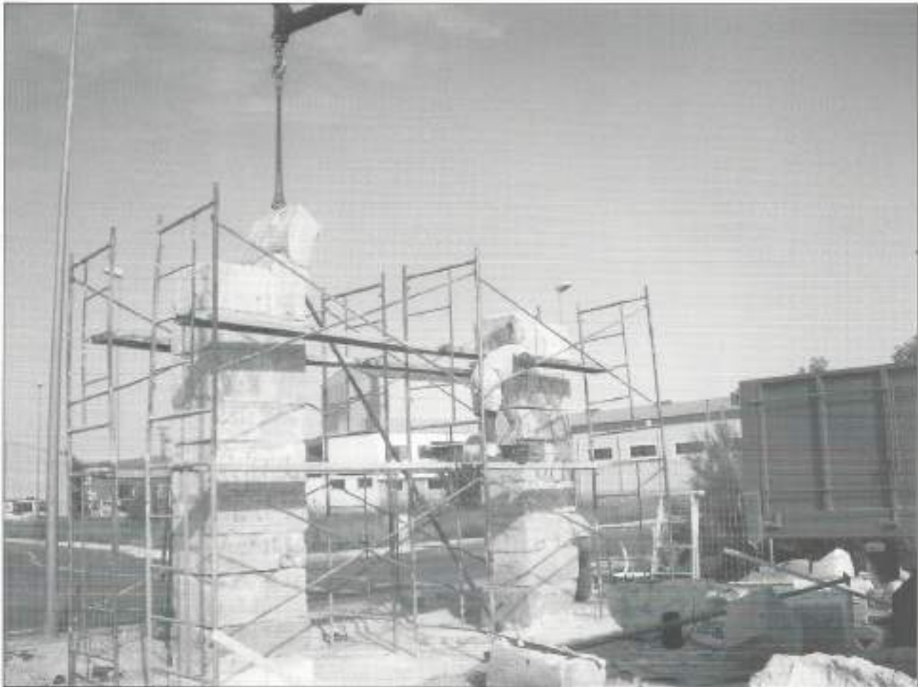
Fig. 5. Proceso de montaje
