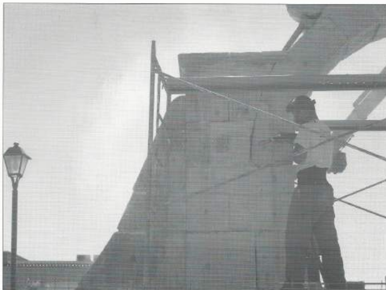
Fig. 6. Detalle, Proceso de limpieza
