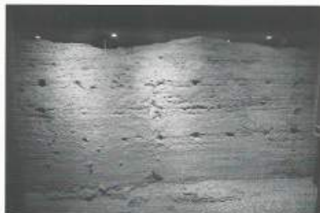
Fig. 11. Paramento exterior del Tramo II de la muralla. Se aprecia la línea de mechinales y la zarpa de la zapata de cimentación. (Foto A. Aragón).
