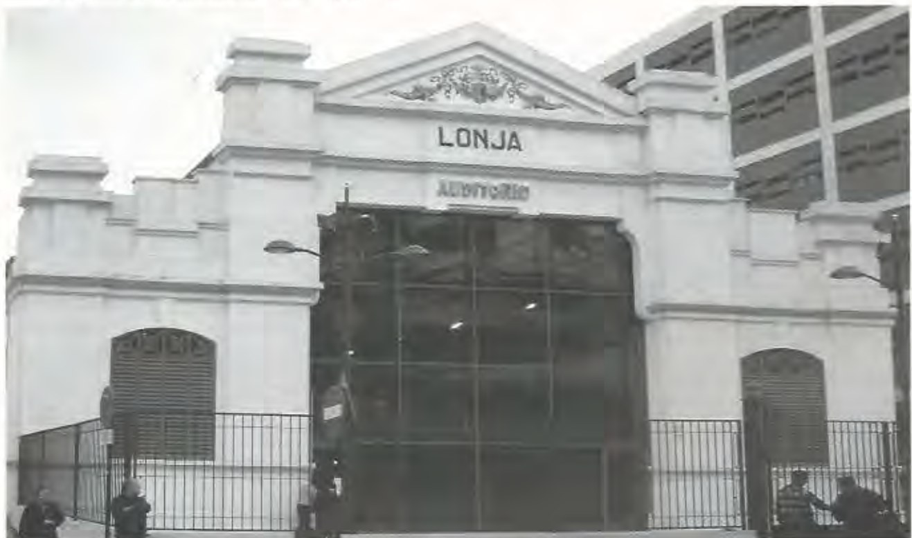
Fachada Principal Auditorio de Orihuela (antes Lonja Municipal). Fotografía estado actual.
