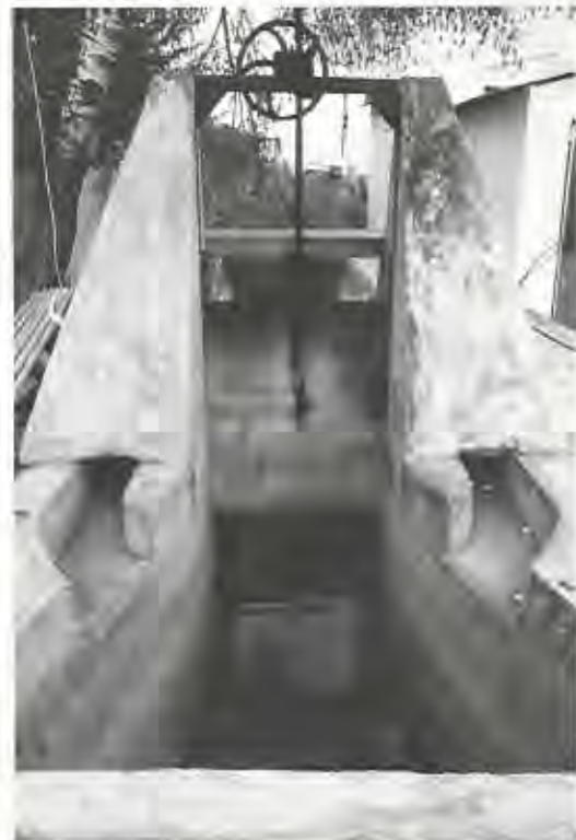
Fig. 4. El sistema de regadío se articula a través de una complicada estructura técnica de esclusas y una red de acueductos que se va adaptando a la ley de la gravedad y a la microtopografía que exige la zona. Todo ello va conformando esta obra maestra de empirismo agrícola que tanta prosperidad ha dado a la zona.
