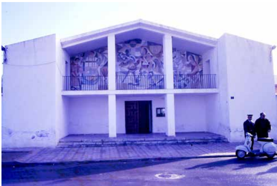
Fig. 11. San Isidro, fachada principal de la parroquia.
