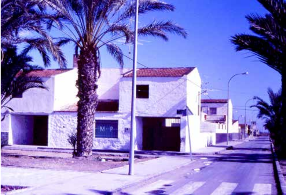
Fig. 24. El Realengo, viviendas.
