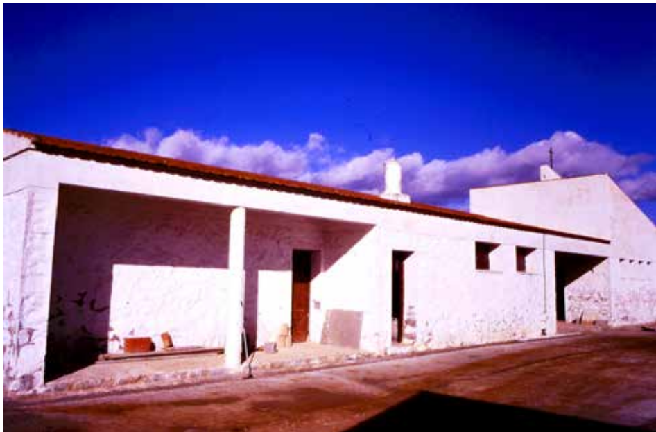
Fig. 20. San Isidro, la fachada del cementerio.
