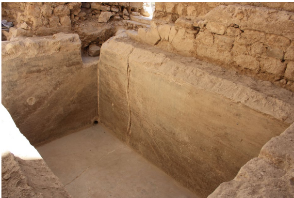
Figura 33: Aljibe en la planta baja de la torre, sellando la puerta original
