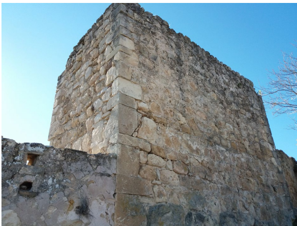
Figura 26: Torre maciza desde el noreste
