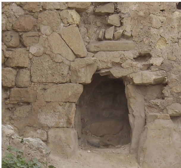
Figura 23: Puerta de la torre
