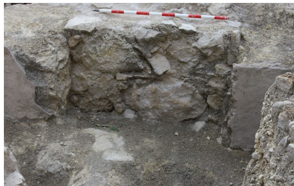
Figura 12: Mampuestos en el recorte del lado oeste UE 5024
