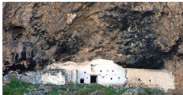
Figura 6: Estado actual del espacio destinado a vivienda (cueva n.º 1)
