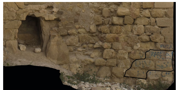
Figura 20: Detalle del paramento al norte de la puerta (UE 10)
