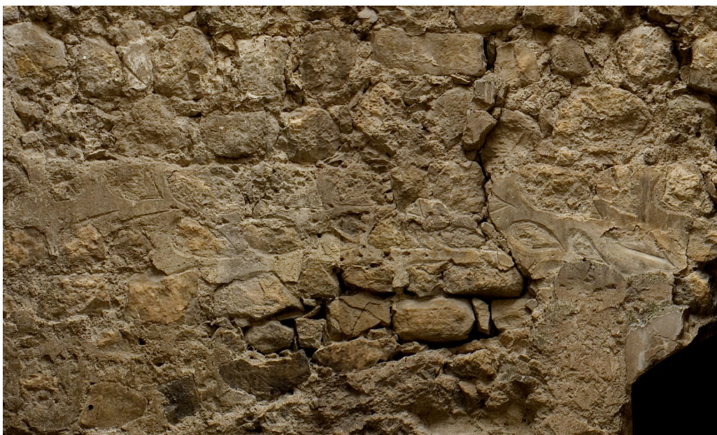
Figura 22: Detalle del enlucido interior
