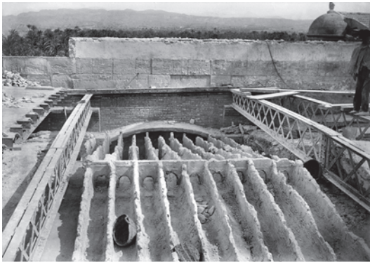
Fig. 2. Obras de sustitución de la cubierta (1904). Fotografía realizada por Pere Ibarra. Propiedad de la familia Serrano Peral y digitalizado por Jerónimo Guilabert.
