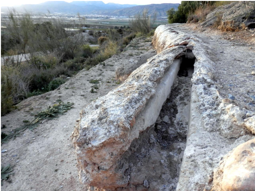
Figura 4. Caño del Barracón. Al fondo de la imagen el valle del Guadalentín y la población de Alhama de Murcia.
