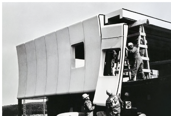
24. COLOCACIÓN MANUAL DE COSTILLA
