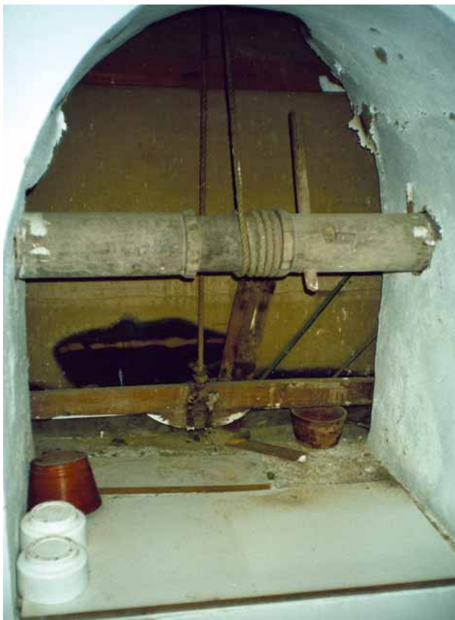
Camarín de Nuestra señora del Carmen. Detalle del sistema de elevación del lienzo bocaporte.
