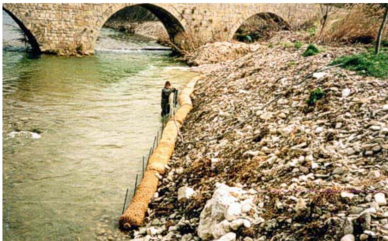
**Foto 1.** Es necesario adaptar las diferentes técnicas de restauración a cada modelo geomorfológico local. En la foto, un intento de restauración de la ribera mediante la colocación de "biorrollos" presembrados y estaquillados. Esta técnica es muy interesante para orillas totalmente estériles. En este caso no prosperó debido a la gran variación de la cota de agua condicionada por el régimen concreto de caudales del río en este tramo.
