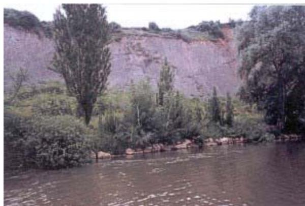
**Foto 2.** Cuando se realiza un buen diagnóstico y el perfil solución dado para cada tramo es el adecuado, las posibilidades de éxito utilizando las técnicas habituales de restauración fluvial son elevadas. En la foto, corrección de un asa de erosión en la orilla mediante reperfilado del talud y colocación de un tacón de escollera ( imagen 1ª) y posterior revegetación mediante siembra, estaquillado y plantación de especies de ribera ( imagen 2ª)
