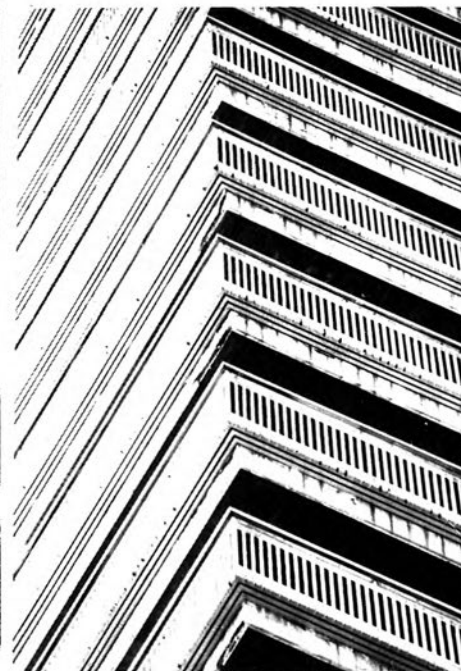
Detalle de fachada.
