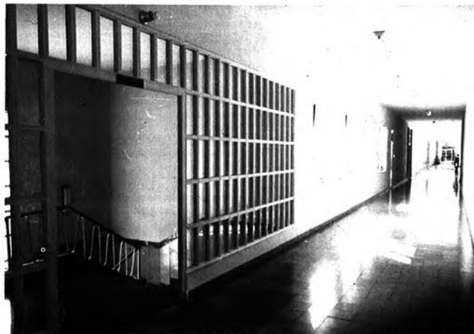
Pasillo interior. Escalera.
