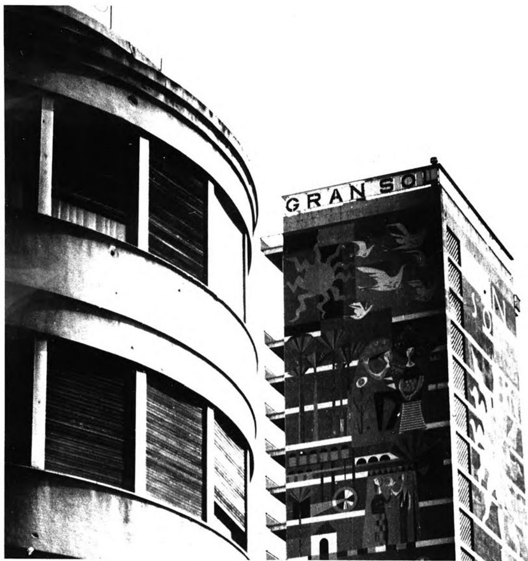
Viviendas C/. Bailén Ang. C/. Teniente Coronel Chápuli, (1935); y Edificio «Alonso» (Hotel «Gran Sol»), (1961).
