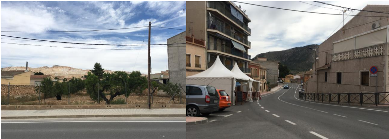
Rambla-Cañada que ingresa en la Romana y vista de la hondonada del cauce desde un lateral de la CV-840, el ingreso de la rambla se sitúa a la altura del coche circulante. Imágenes propias.
