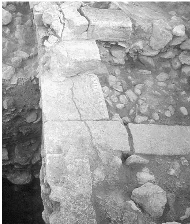
Figura 4: Atirantado del forro de sillares reemplazados en la muralla visigoda.
