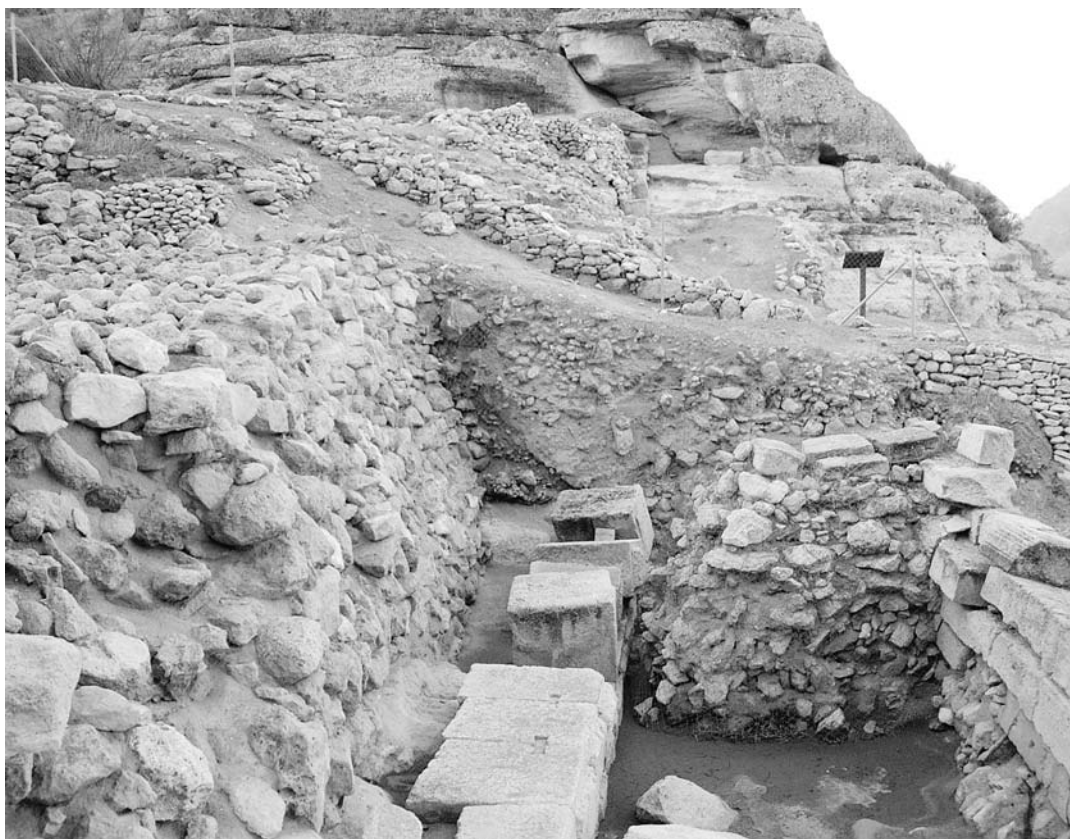
Figura 5: Relleno del baluarte visigodo englobando en su interior la muralla romana.
