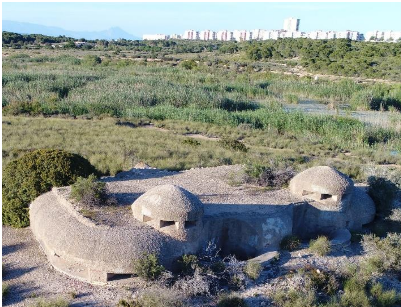
Figura 3. Fotografía actual del búnker principal (CG-BK04.elc) tomada desde el dron; en primer plano el frente sur con los diversos elementos defensivos (aspilleras, escotillas y fosos) para alojar el armamento; por detrás quedan las lomas de Arenals y de Cabeçó, las urbanizaciones turísticas y, en último plano, el Puig-Campana en las cordilleras al norte de la provincia de Alicante (foto: autores)
