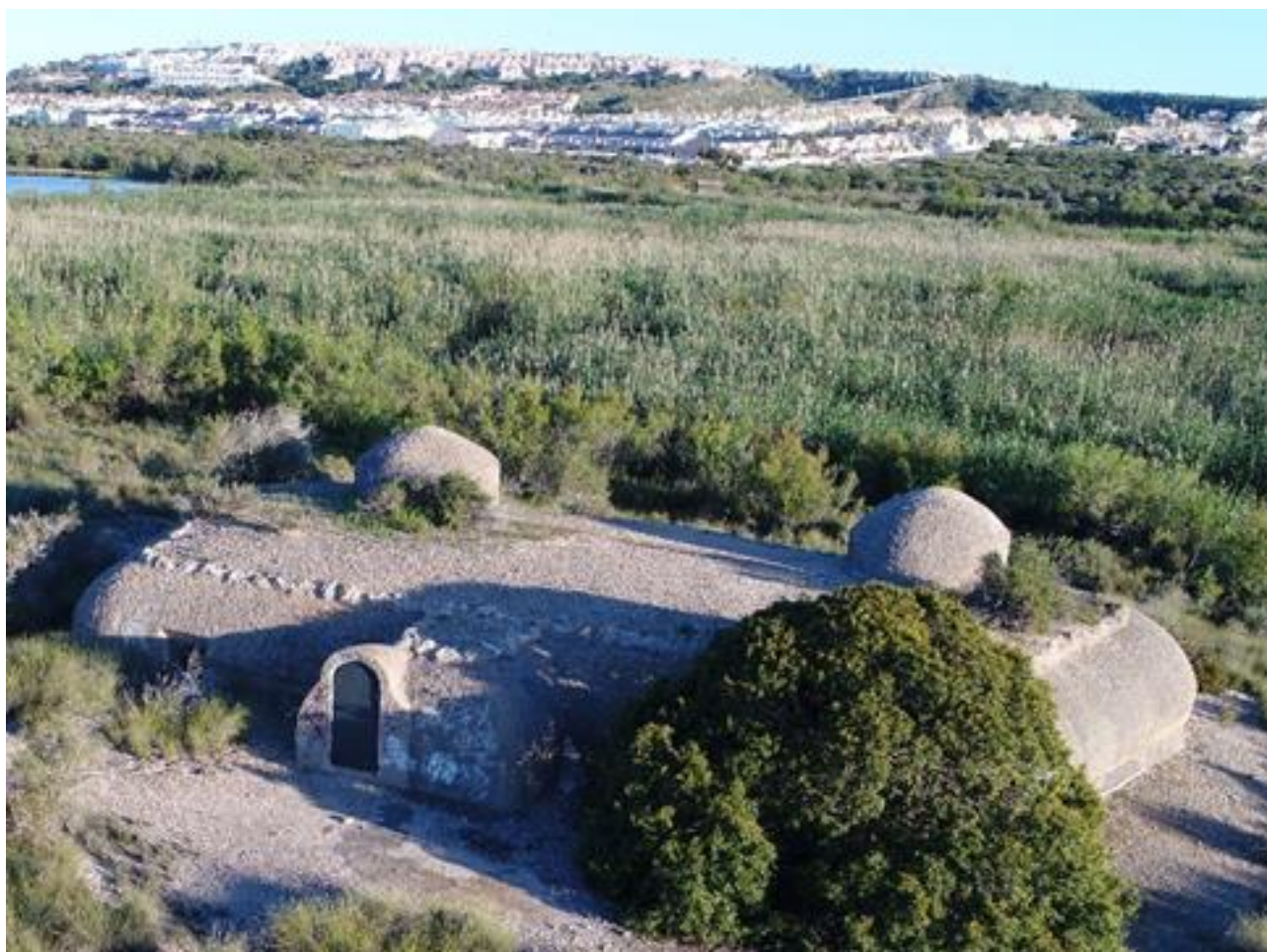
Figura 4. Fotografía actual del búnker principal (CG-BK04.etc) tomada desde el dron; en primer plano el frente norte del búnker con el único acceso a su interior por la parte de refugio y la superficie superior con los volúmenes de las escotillas sobresaliendo; por detrás, la laguna y, al fondo, se observan las urbanizaciones turísticas sobre la sierra y el cabo de Santa Pola (foto: autores)
