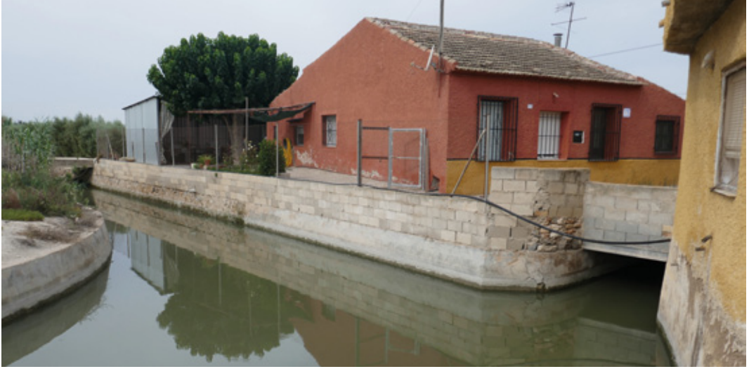
Figura 6. Arranque del Azarbe de la Reina que recoge los sobrantes de la Acequia Mayor de Almoradí y los drenajes del Azarbe Viejo, cauces a derecha e izquierda, respectivamente. Fuente: fotografía de G. Canales.
