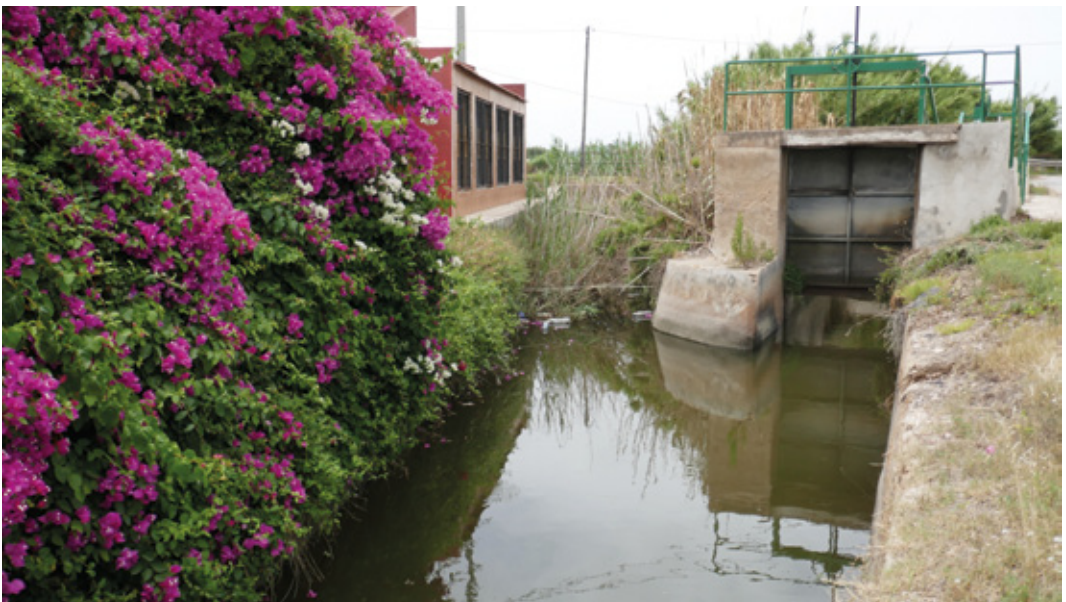
Figura 4. Compuerta de inicio de la Acequia de Mudamiento en el Azarbe de Millanares, donde confluye por la izquierda de la imagen el Azarbe de Rosa Mazón. Fuente: fotografía de G. Canales.
