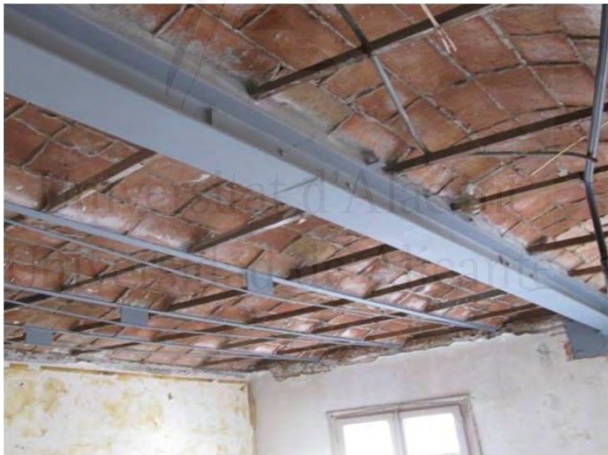
Fig. 7. Rehabilitación de forjado mediante vigas metálicas ( https://www.albatrosconstruccion.com )
