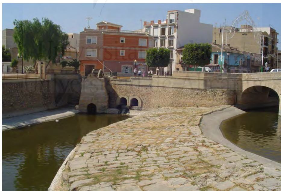
Fotografía 59. Conjunto hidráulico de Rojas (Bajo Segura). Vista parcial del puente de Carlos III, con el azud en primer término y la noria al fondo.
