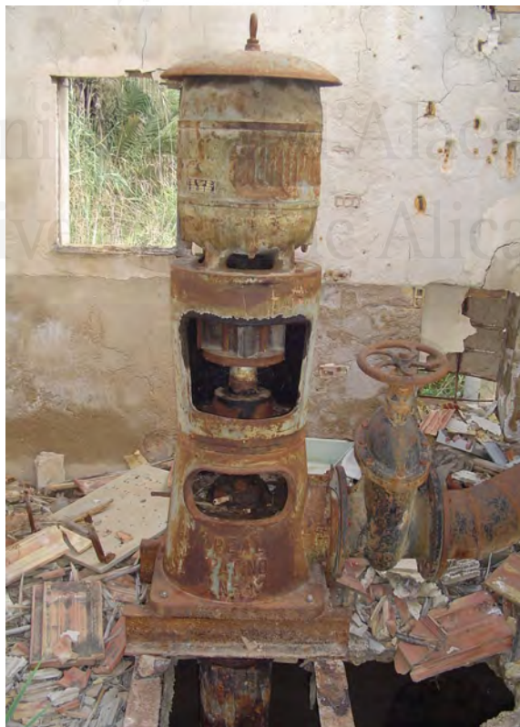
Fotografía 74. Bomba para elevar agua (San Isidro, Bajo Segura).
