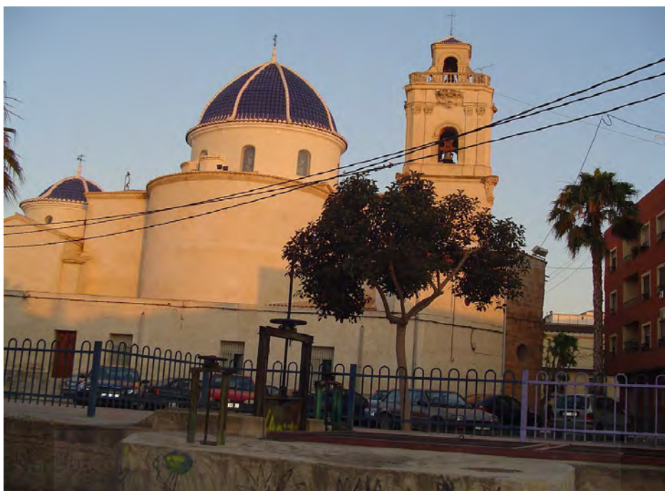
Fotografía 37. Acequia de Callosa a su paso por Catral (Bajo Segura), donde se observa la iglesia de los Santos Juanes. En el casco urbano de Catral se configura un hábitat caminero, surgido junto al curso de esta acequia.
