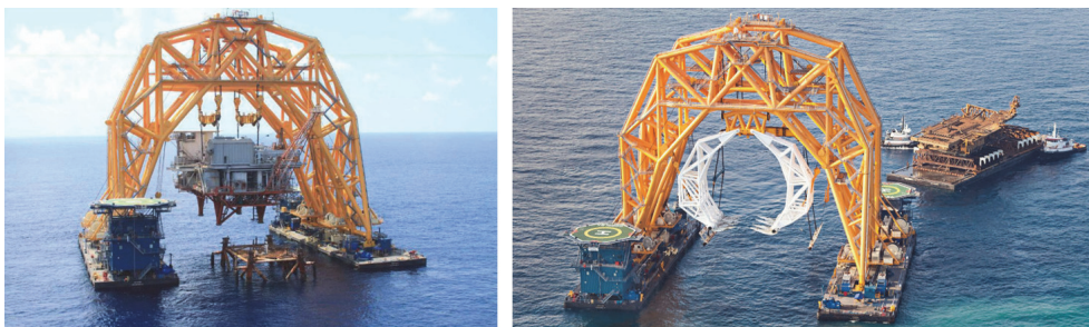
Fig. 2. A la izquierda, el Versabar VB-10.000 instalando un topside. A la derecha, con la herramienta “garra” instalada
