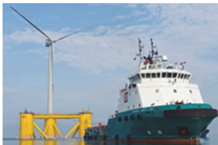
Fig. 4. El Bourbon Liberty 228 durante la instalación del Windfloat I (Portugal)
