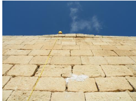
Fig. 14- Medición del frente murario sur (foto autor, 2009)
