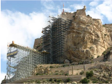
Fig. 8- Andamio tipo europeo instalado para las obras de consolidación (foto autor, 2008)
