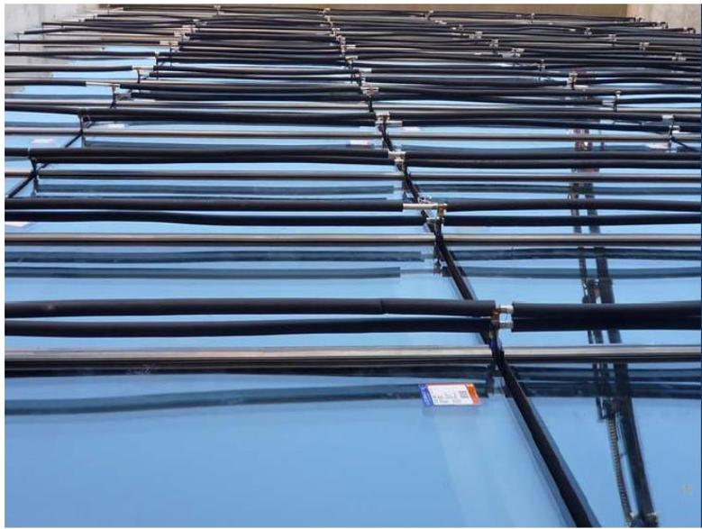
Figura 50. Circuito hidráulico muro cortina UCLM con sistema Intelliglass. Fuente: Intelliglass
