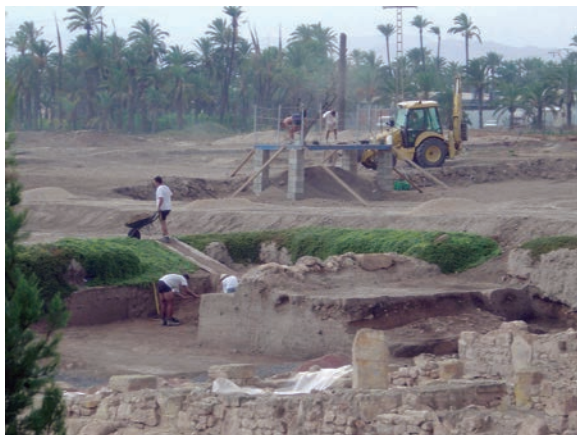
Fig. 6: Reperfilado de la zona central y cribado de antiguas terreras (2003).
