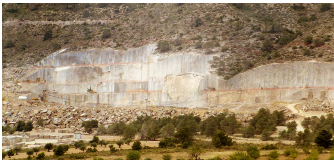
Figura 3.52. Vistas generales de varios frentes de explotación de mármoles Marrón Emperador en la zona W de la Sierra de la Magdalena.
