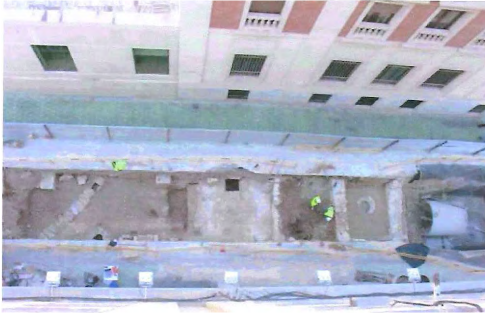
104 - Otro detalle de las cimentaciones
