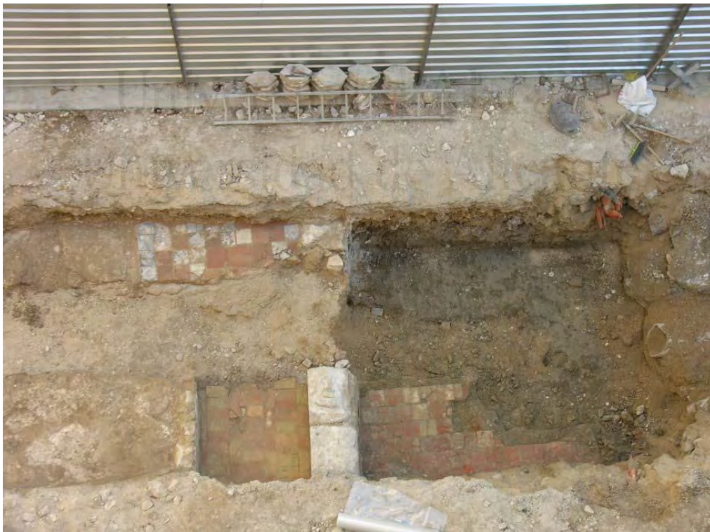
124 - Diferentes habitaciones con pavimentos de losetas y de cemento hidráulico. Espacios cortados por una tubería reciente de uralita
