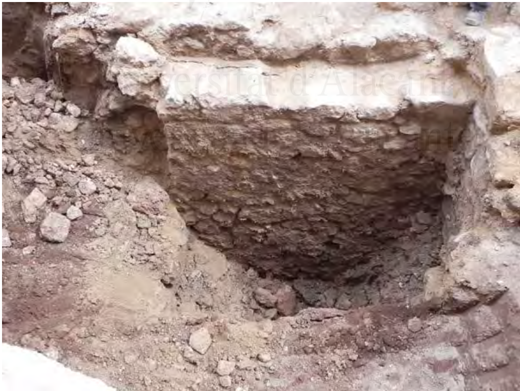
121 - Pared sur de la estructura de la noria
